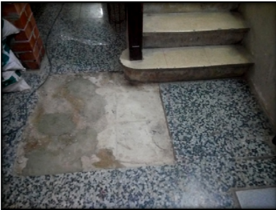
F1. Fossat 1 (paviment UE 01 i preparació UE 02).
