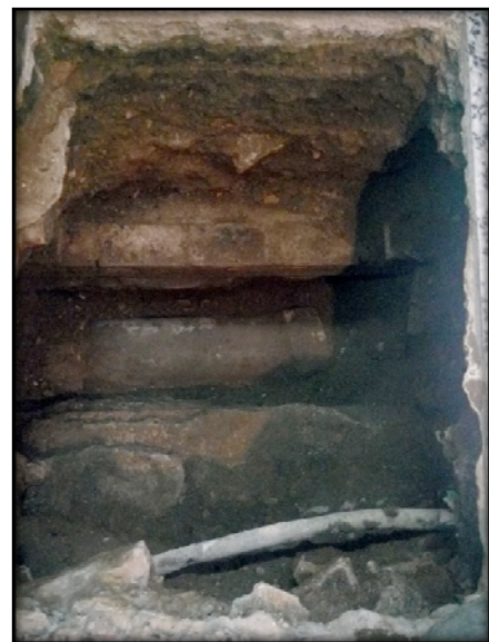
F4. Fossat 1, canonada de formigó UE 06.
